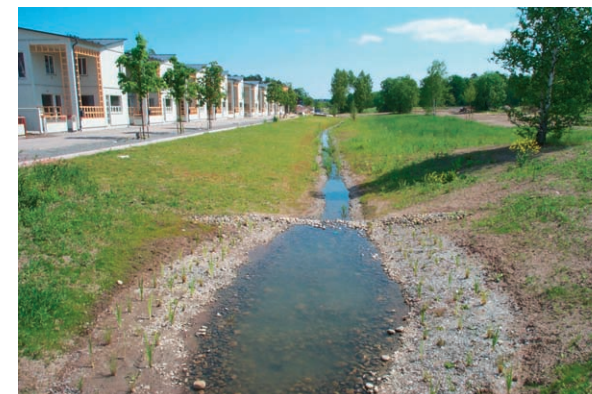
Småskalig bebyggelse som vetter mot en liten bäck. Exempel från det nybyggda Silverdal i Sollentuna.
